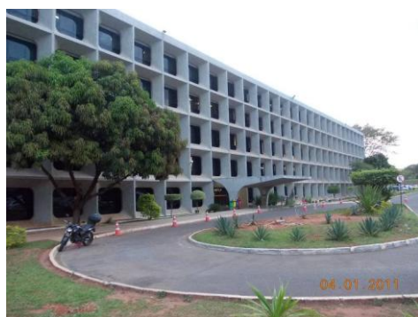
Figura 1.20 – vista lateral do prédio Anexo
