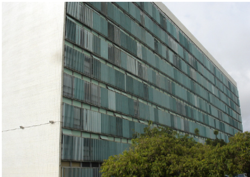
Figura 2 – Fachada Oeste do prédio do Ministério de Minas e Energia.
