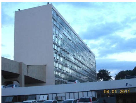
Figura 1.22 – equipamento de climatização utilizado nos seis primeiros pavimentos do prédio sede
