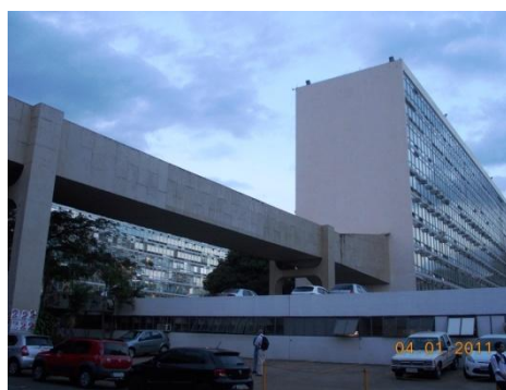
Figura 1.21 – passarela utilizada para interligar o prédio sede e os anexos
