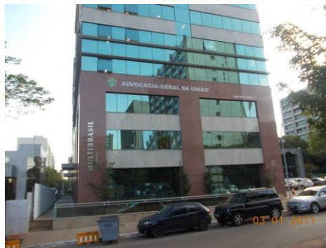
Figura 1.27 – vista da frente do prédio
