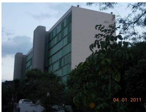
Figura 1.2 – fachada típica - oeste
