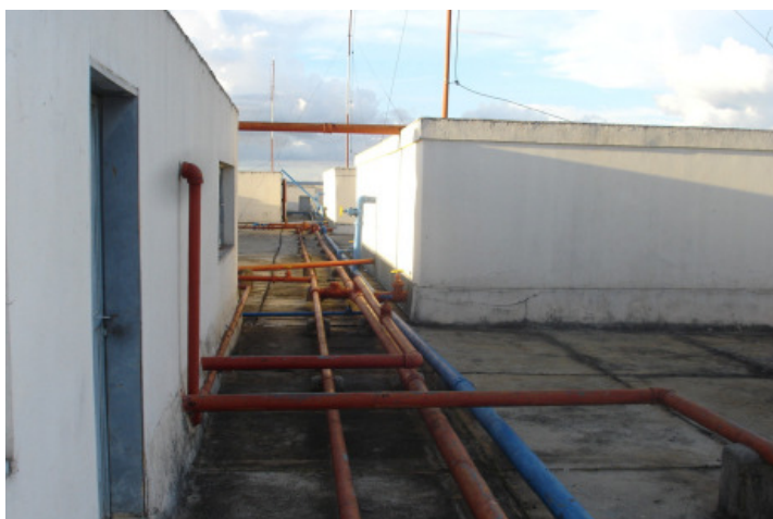
Figura 6 - Imagem da cobertura do prédio do Ministério de Minas e Energia.
