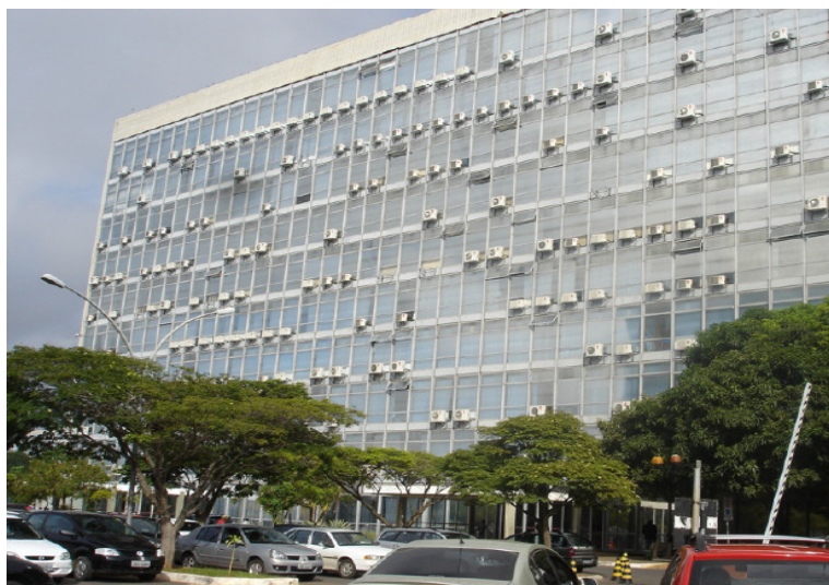
Figura 1 – Fachada Leste do prédio do Ministério de Minas e Energia.
