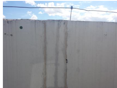
Tratamento das juntas vertical de dilatação, pelo lado interno da platibanda (4 pontos)
