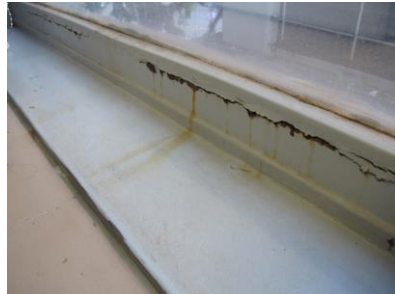
Detalhe de infiltrações pelas esquadrias metálicas
