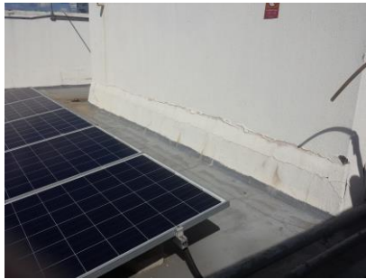
Lado inferior da parede do reservatório ala norte
