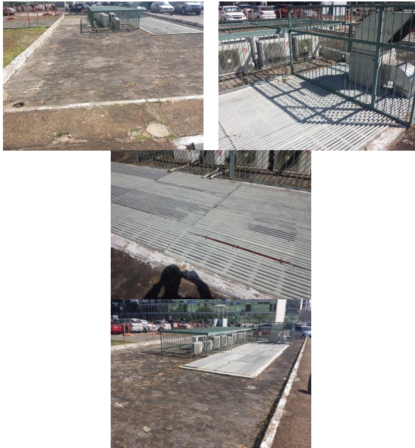
Sobre a laje da área de convivência do Centro de Treinamento
