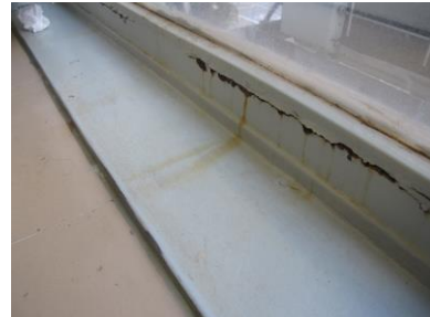
Detalhe de infiltrações pelas esquadrias metálicas
