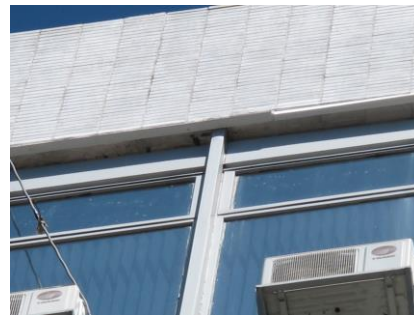
Revestimento cerâmico superior empena leste
