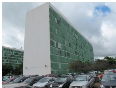
Revestimento cerâmico fachada norte
