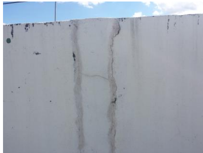
Tratamento das juntas vertical de dilatação, pelo lado interno da platibanda (4 pontos)
