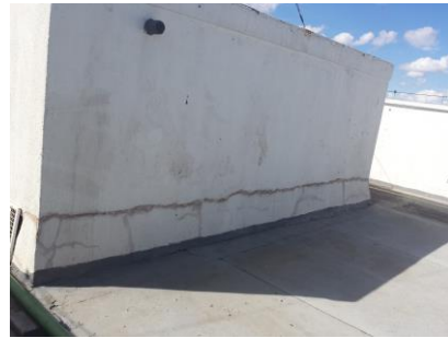
Lado inferior da parede do reservatório ala sul
