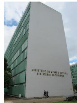
Revestimento cerâmico fachada sul
