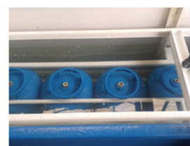
Teste de Vazamento
