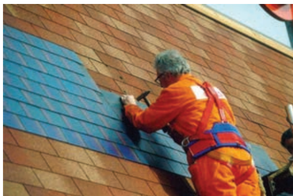
Figura 15 – Módulo fotovoltaico integrado a fachada
