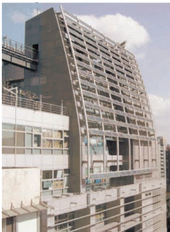
Figura 12 – Módulos fotovoltaicos instalados em brises
