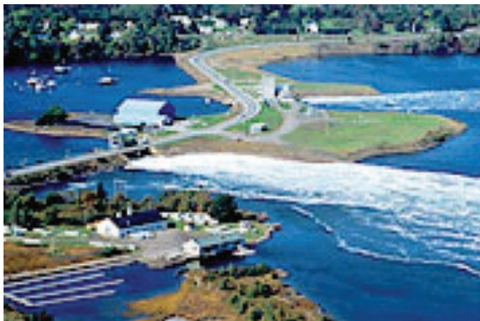
Figura 6 - Usina maremotriz de Annapolis, Canadá
