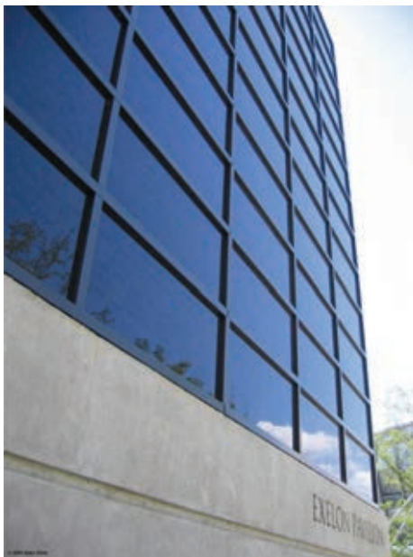
Figura 14 – Módulo fotovoltaico integrado aos vidros
