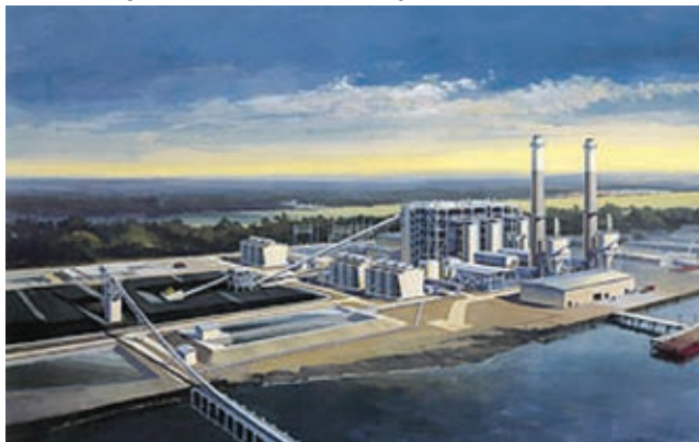
Figura 10 – Usina termelétrica junto à mina de carvão
