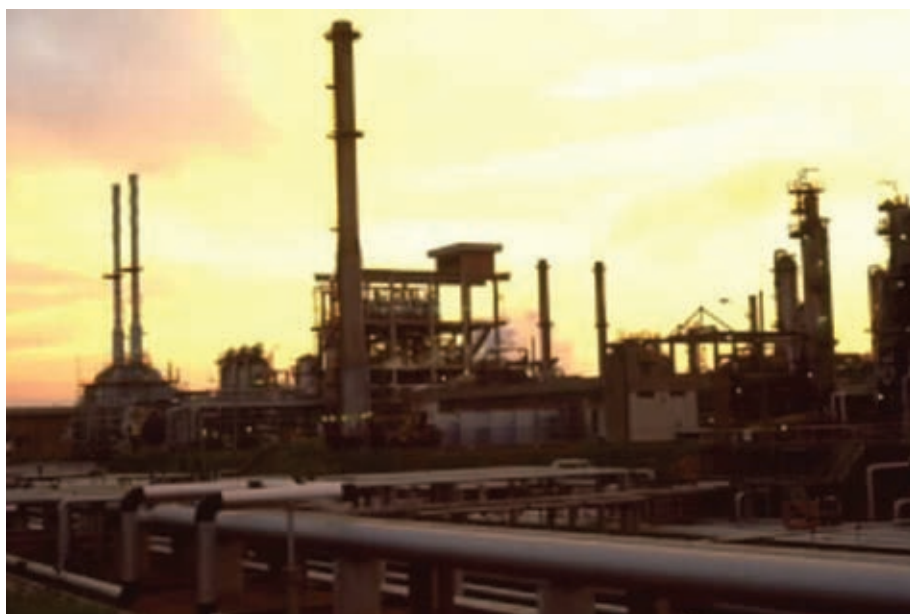
Figura 6 – Fotografia de refinaria
