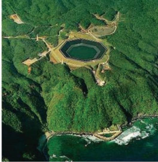
Usinas reversíveis são indicadas onde há necessidade de capacidade extra de geração nas horas de demanda máxima. Uma vez que suas turbinas podem ser usadas como bombas, pode-se transferir água de um reservatório a jusante para o de montante nas horas de carga leve. A água assim acumulada é “devolvida” ao reservatório de jusante nas horas de ponta, acionando as turbinas e gerando energia elétrica em um horário especialmente crítico para o sistema.
