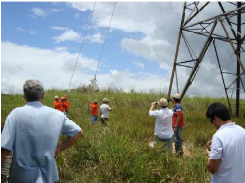
Figura 4: Instalação do DONUT numa torre da LT Blumenau - Palhoça
