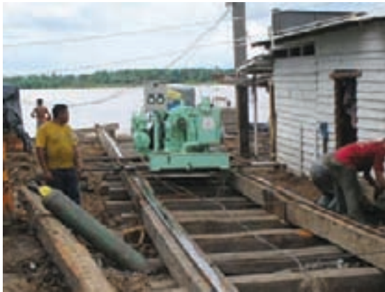
Figura 11.11 – Transporte da turbina até o local de instalação
