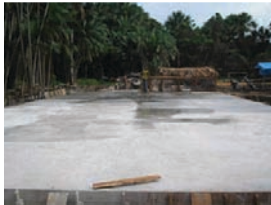
Figura 11.8 – Detalhes da construção da laje da fábrica de extração de óleo vegetal
