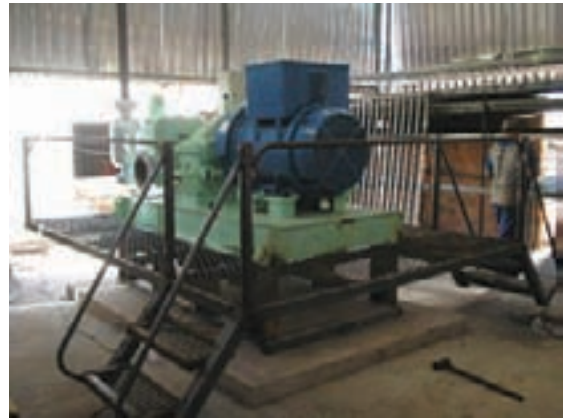
Figura 11.12 – Turbo-gerador já instalado em sua base
