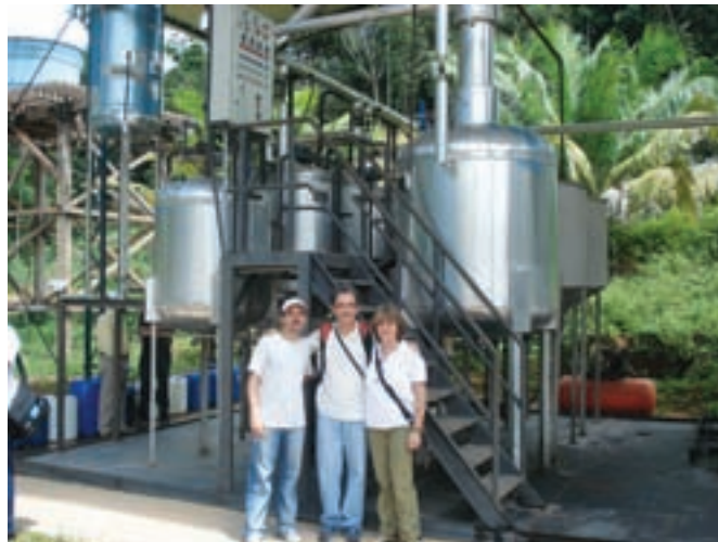
Figura 8.1 – Usina de biodiesel do projeto
