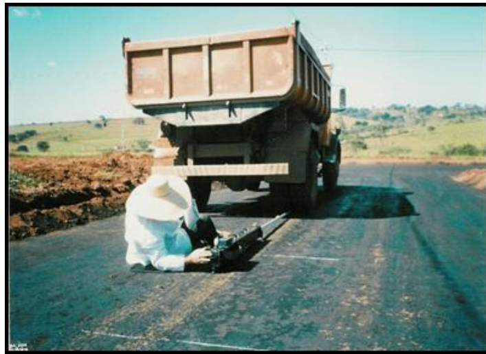
Figura 28. Ensaio de Viga Benkelman
