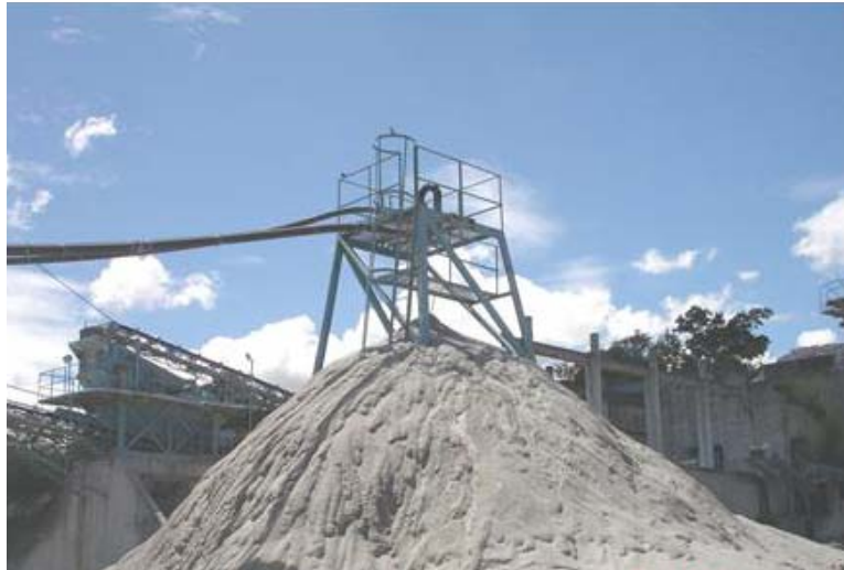
Figura 18. Hidro-ciclone e pilha de resíduo da Pedreira 1
