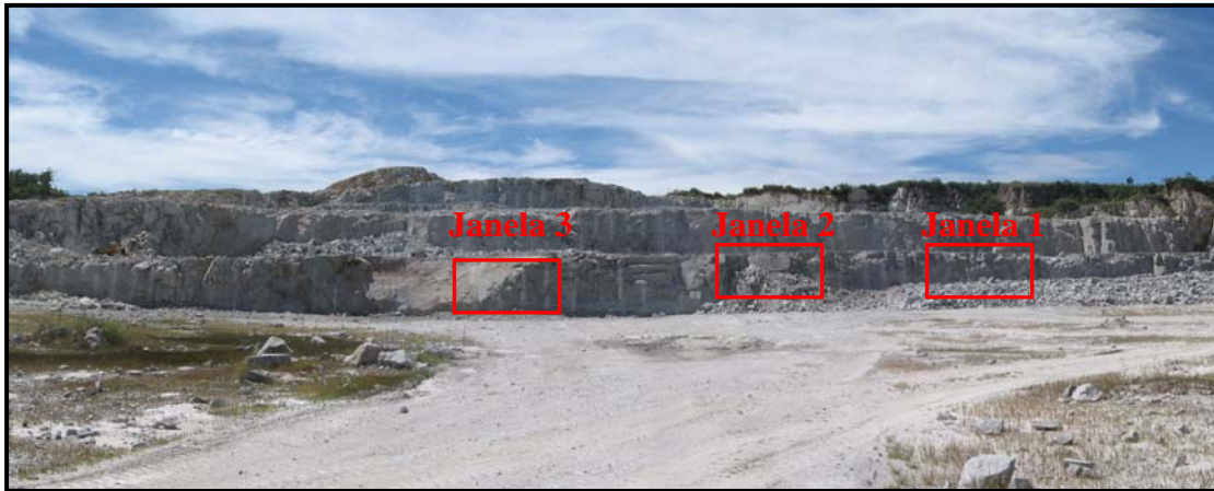
Figura 12. Localização das janelas de amostragem – Pedreira 1
