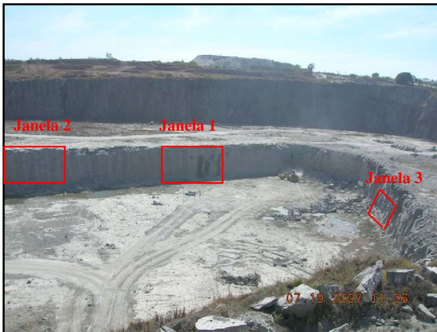
Figura 13. Localização das janelas de amostragem – Pedreira 6
