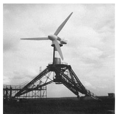
Turbina eólica experimental em Nogent-le-Roi, França - operou entre 1958/62 (800 kW).
