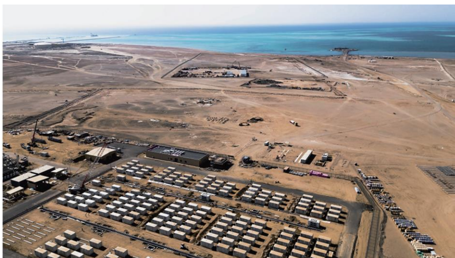
Figura 12: Projeto de armazenamento de energia de microrrede de 1,3 GWh no Mar Vermelho, Arábia Saudita.
