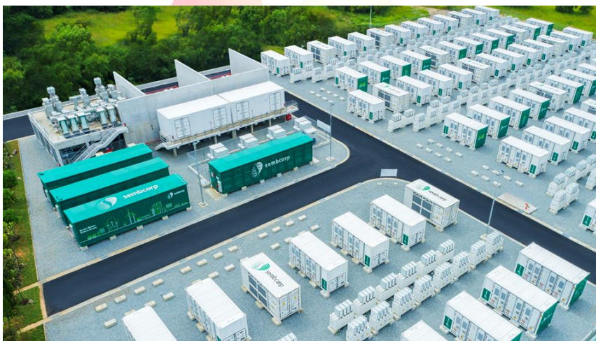
Figura 11: Sistema de armazenamento de energia Sembcorp
