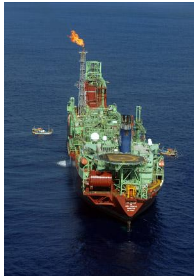
Teste de Longa Duração de Tupi Navio-plataforma FPSO Cidade de São Vicente
