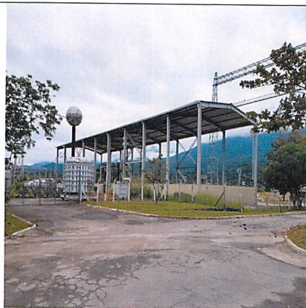
Galpão Metálico (Cepel Adrianópolis - Nova Iguaçu – 05/06/2018)
