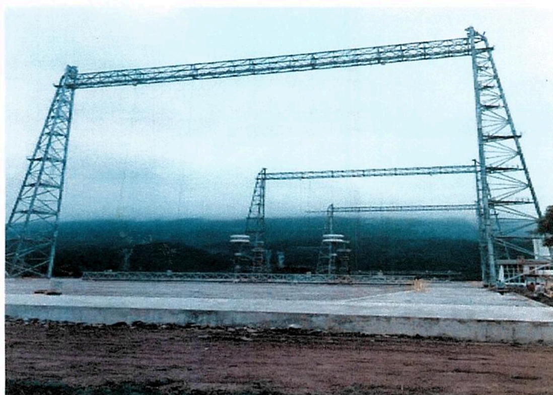
Visão geral dos Pórticos (sul para Norte – Meta 12)
