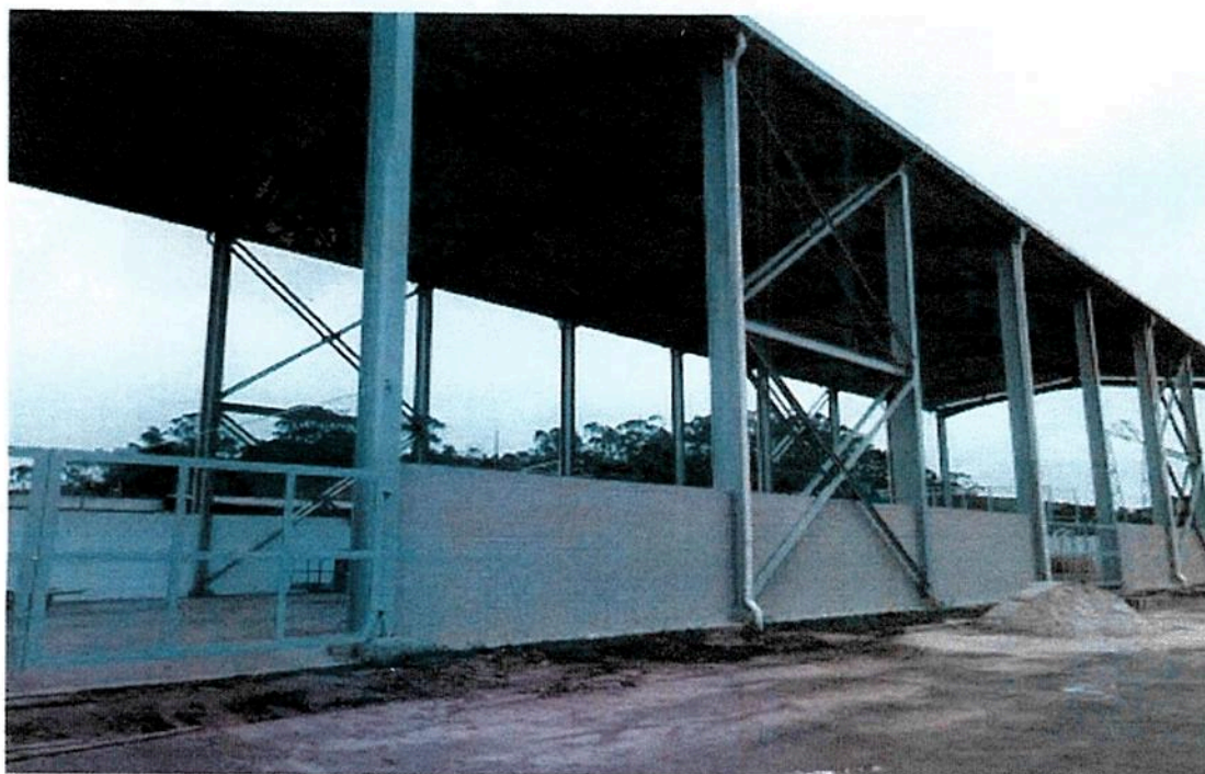
Galpão – Obras civis – Meta 11
