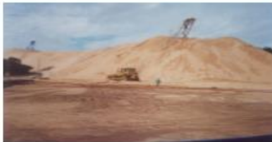
Rejeito sendo preparado para recompôr uma nova duna
